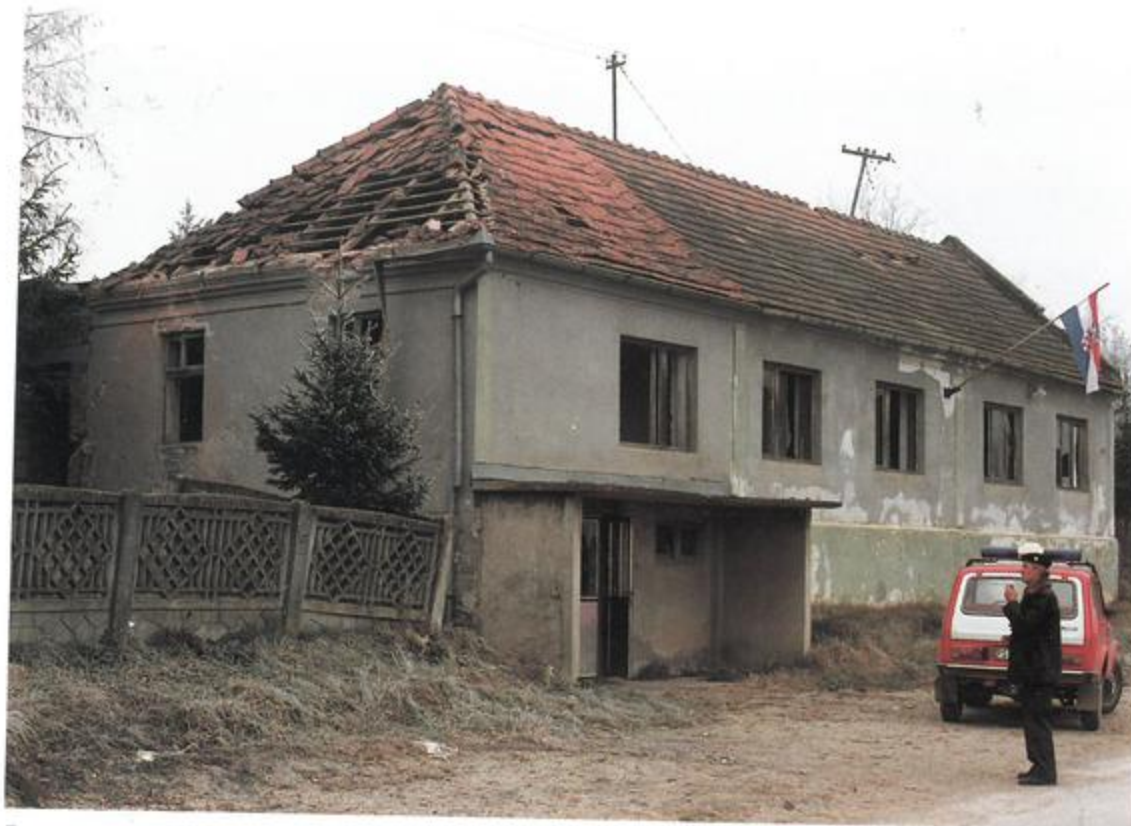
Dom Dobrovoljnog vatrogasnog društva u Četekovcu (Općina Podravska Slatina) oštećen u nemilosrdnim ratnim razaranja.
